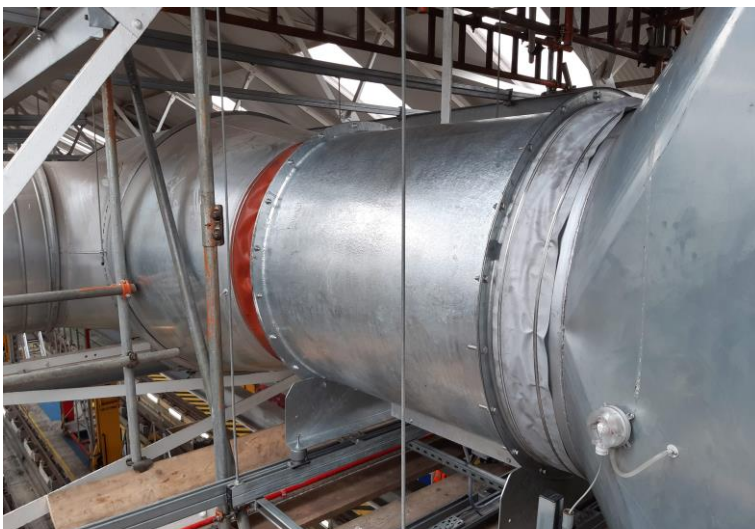
New fan installed
